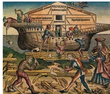
LES CHARPENTIERS A L'OEUVRE
